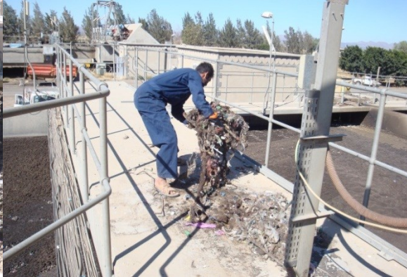
صورة (4) إزالة المخلفات الصلبة من أحواض التهوية
