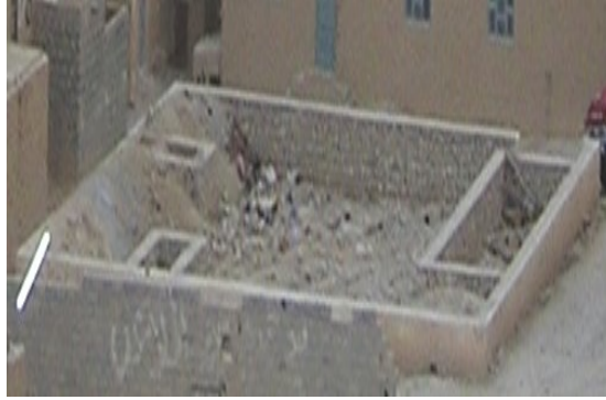
شكل رقم ( 4-2-1) يوضح تكوين أساس الحوائط من الحجر الكلسي بعرض لا يقل عن 40 سم.
