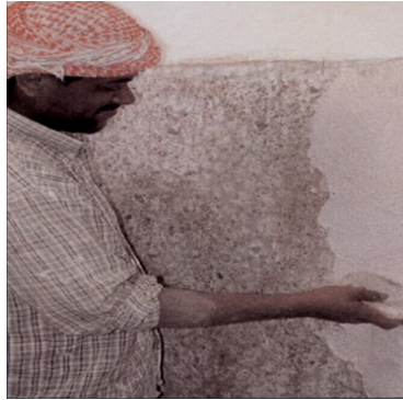
شكل رقم ( 4-2-2 ) يوضح عملية التلييس بالنورة التي تستخدم مع المدر وتشكل طابعاً عاماً للواجهات بوادي حضرموت
