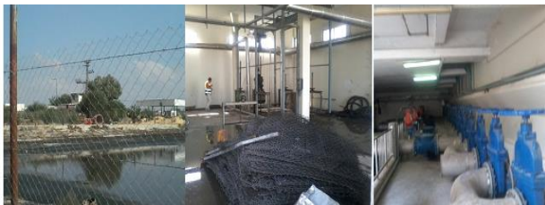
الشكل (2). محطة بيت لاهيا لمعالجة مياه الصرف الصحي، (المصدر: الباحثون).
