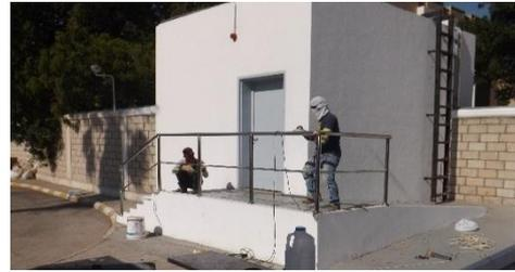
الشكل (28-1): مخزن المواد المشعة مركز الأورام بجده اثناء مرحلة التشطيب النهائي الغرفة مبنية بالكامل من الخرسانة المسلحة لمنع التسرب الاشعاعي، وتظهر رصيف التداول للحاويات المجهز بمنحدر.
