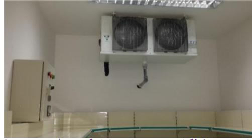
الشكل (27-1): غرفة التبريد بمخزن المواد المشعة مركز الأورام بجده، وتظهر بالصورة وحدات التبريد الخاصة بالغرفة.
