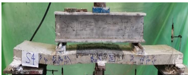
(d) Crack pattern of specimen S_4
