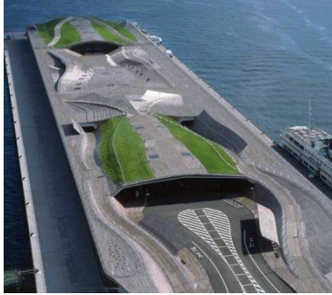
شكل رقم 10 يوضح التصميم الخارجي لمطار Yokohama International Passenger Terminal (Langdon, 2014)
