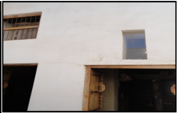
صورة (1) استخدام الجبس الأبيض في ترميم جدران بيت البيعة، وتلاحظ فيها التشققات.
