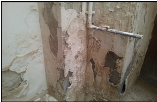
صورة (2) استخدام الإسمنت البورتلاندي في ترميم جدران المدرسة الأميرية.
