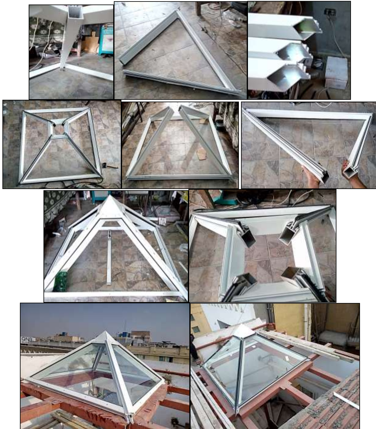
شكل (7) يوضح الوحدة التكرارية للسقف المعدني بعد تنفيذها باستخدام التصنيع الرقمي
