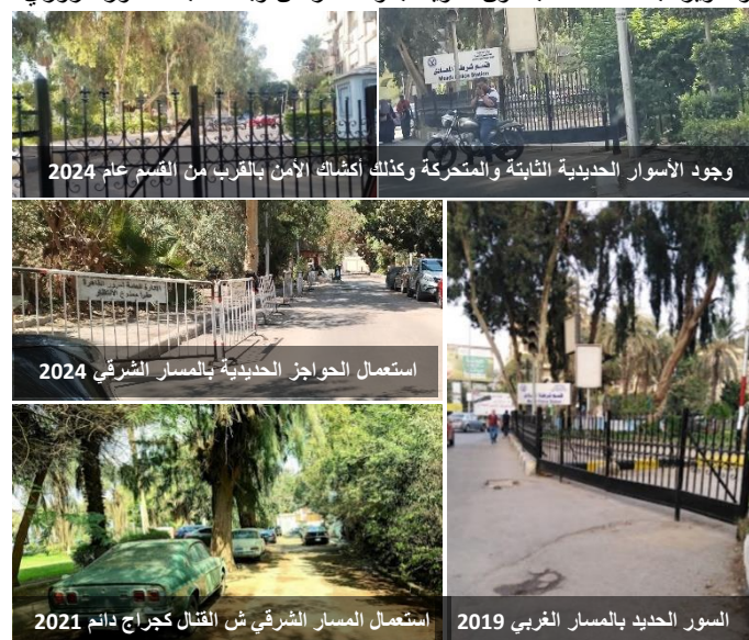
شكل (42) صور لتوضيح استعمال بعض الحواجز الحديدية الثابتة والمتحركة بالقرب من قسم الشرطة لنواحي أمنية بخلاف استعمال المسار الشرقي كجراج دائم (بواسطة الباحث، 2019-2024)
